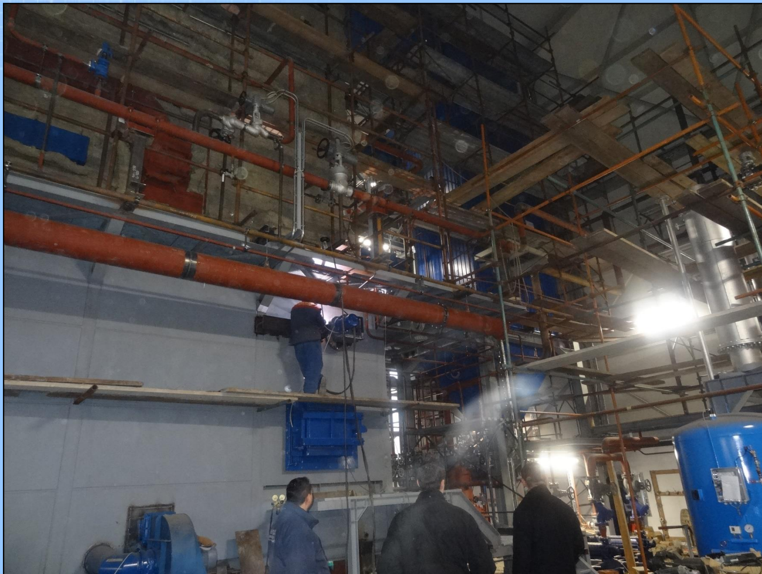
Pogled na parni kotao u gradnji – TPK EPO Zagreb
