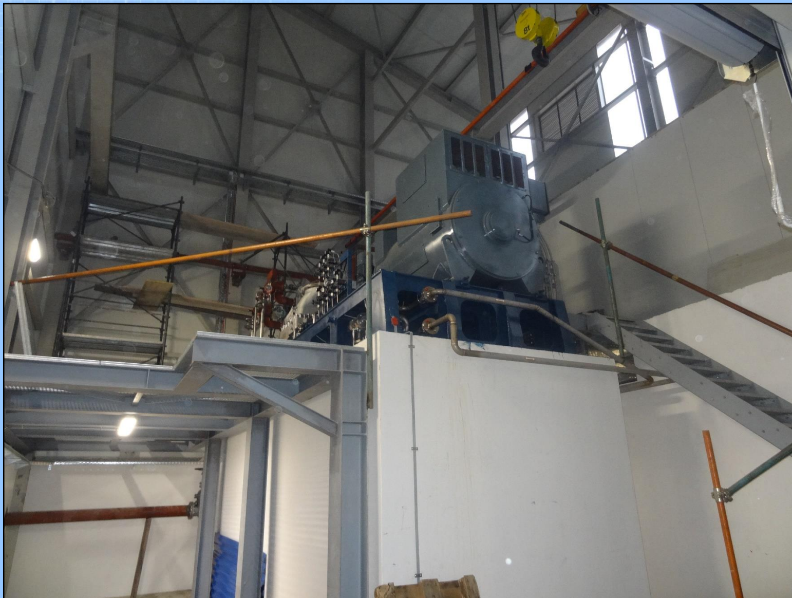
Smještaj agregata na temelju u strojarnici
