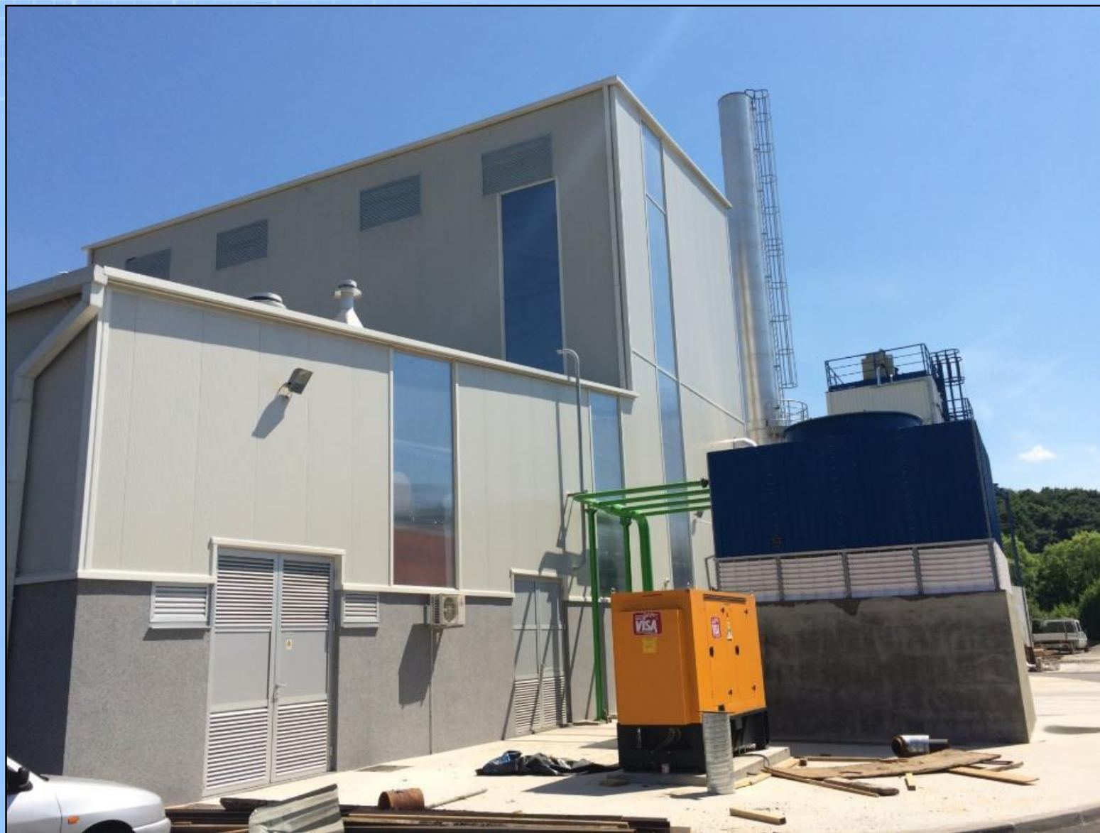
Strojarnica BE-TO Glina – pogled na rashladni toranj
