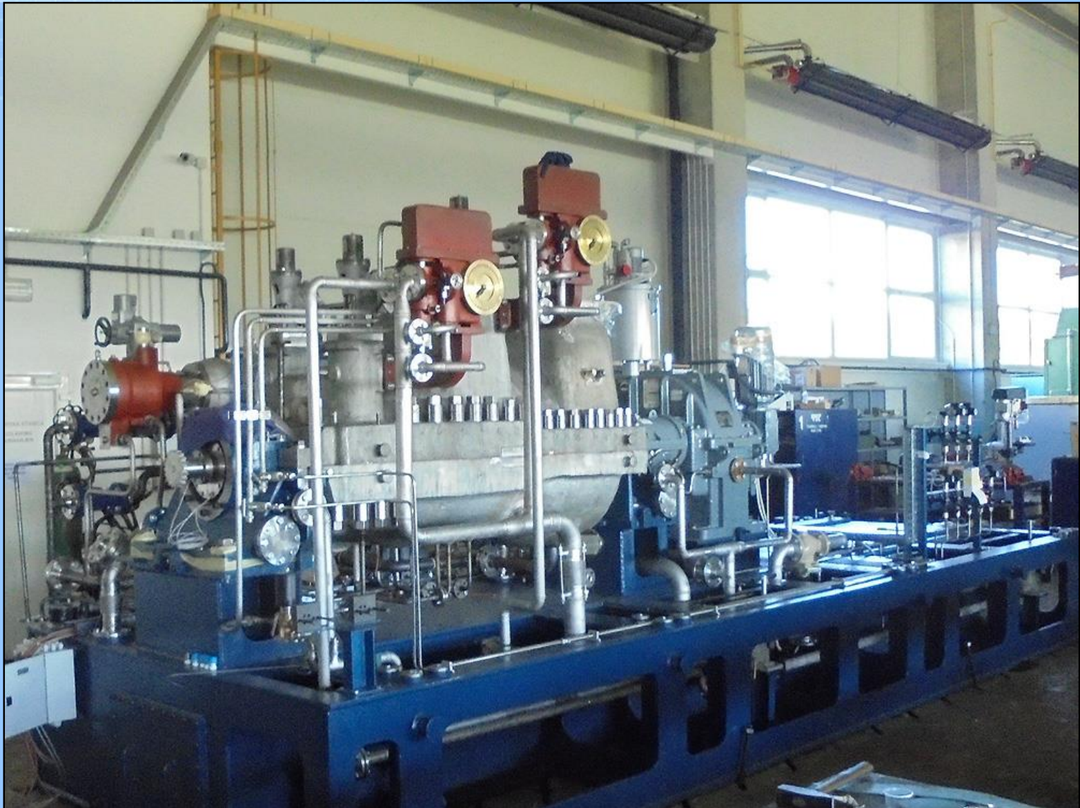
Završna montaža turbine 2,0 MWe BE-TO „SAVA” Stara Gradiška u TTK
