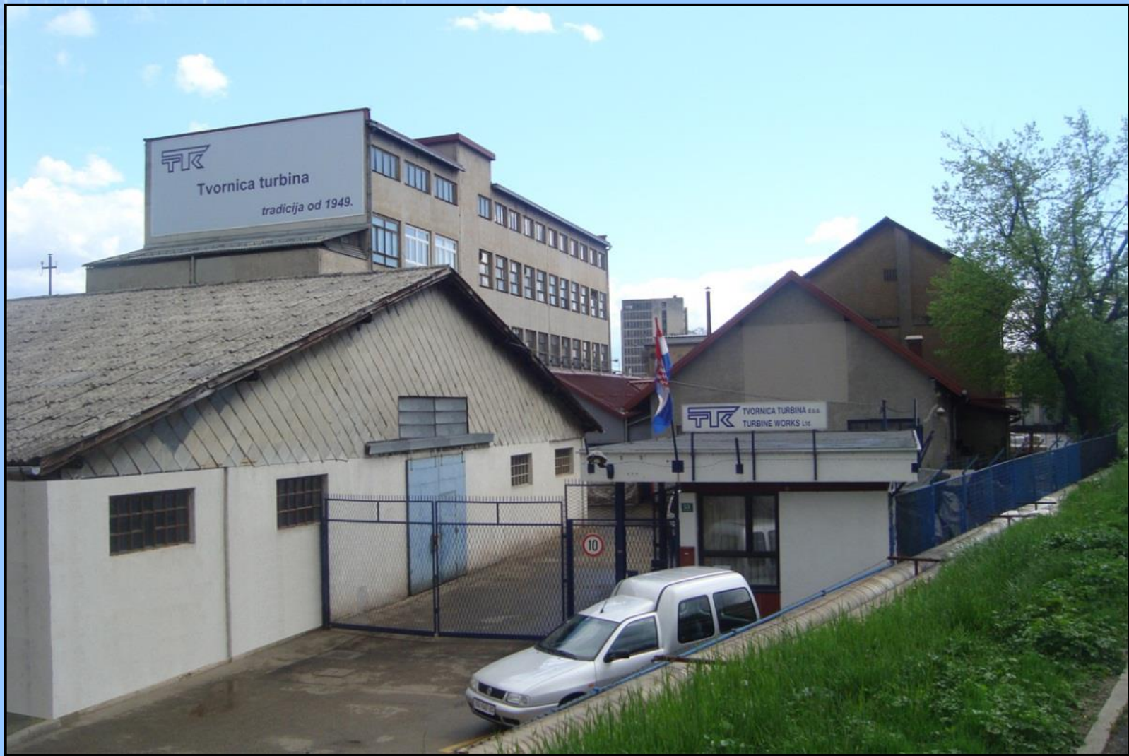
Uprava i proizvodni pogon I – Banija, Karlovac Zgrade sagrađene kao kožare u periodu 1920.-40.godine danas pod zaštitom spomenika kulture
