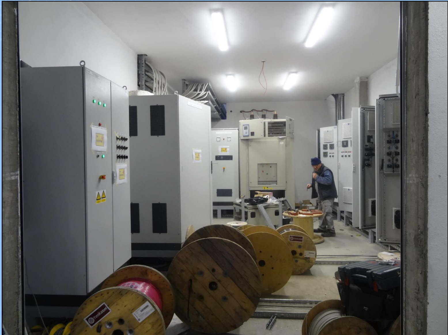
Montaža elektro opreme
